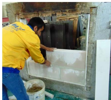
شکل ۴: اجرای بلوک‌های AAC در قاب کوره توسط شرکت سیلیس آرا
