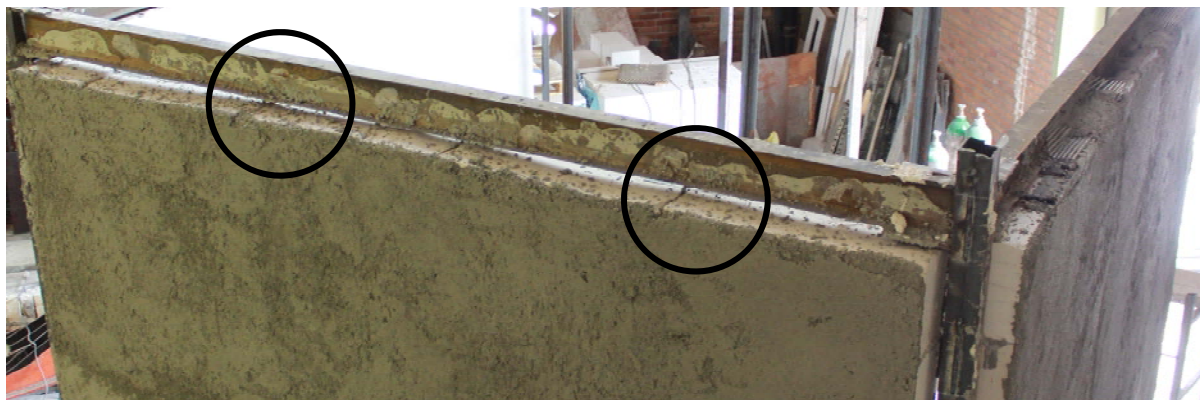
شکل (پ ۱-۱۹) نمایی از بست های انعطاف پذیر اجرا شده در دیوار شماره (۱) برای اتصال به تیر فوقانی
