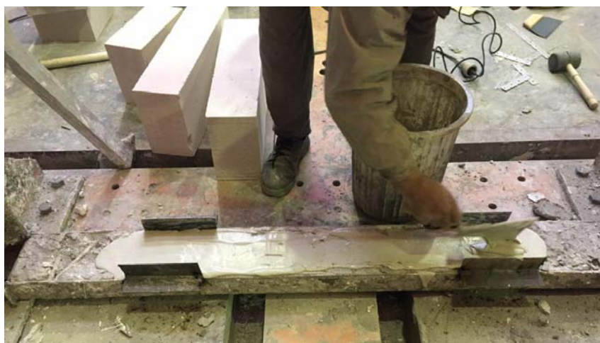
شکل (پ ۱-۶) ریختن ملات در زیر اولین ردیف بلوک‌ها
