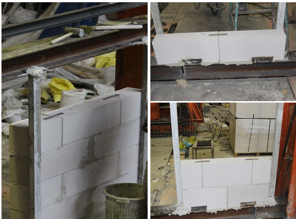
شکل (پ ۲-۴) جزئیات ساخت دیوار AAC
