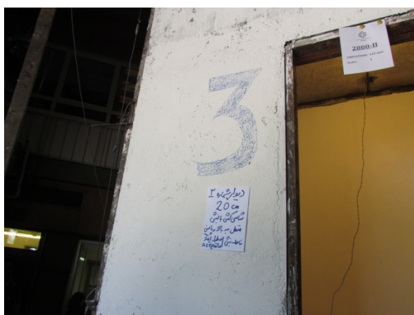
شکل (پ ۱-۱۵) نمایی از دیوار شماره (۳)
