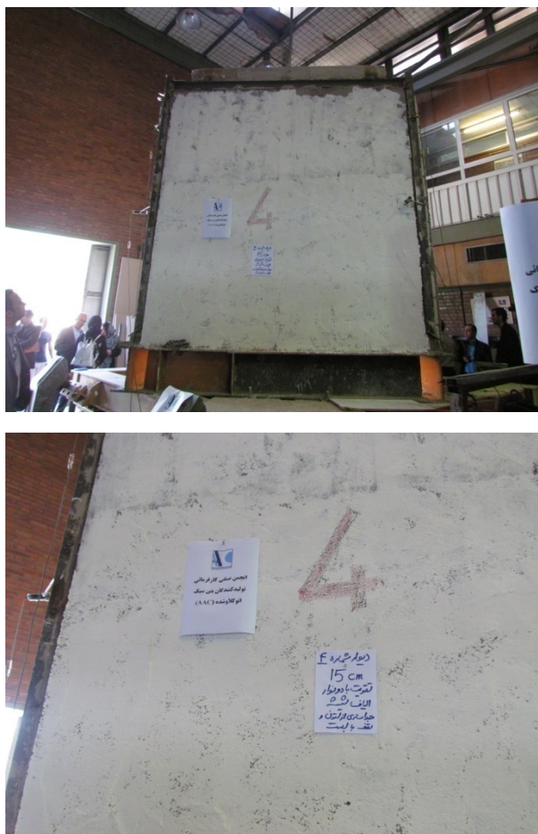
شکل (پ ۱-۱۶) نمایی از دیوار شماره (۴)
