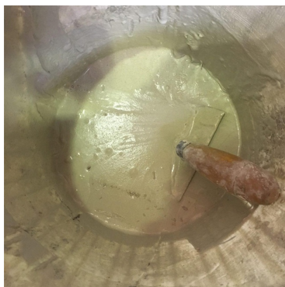
شکل (پ ۱-۵) ملات SILEX مخصوص اجرای تیغه های AAC
