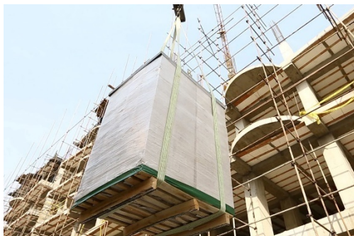
شکل (۴-۱) حمل پالت‌های انتقال بلوک‌های AAC
