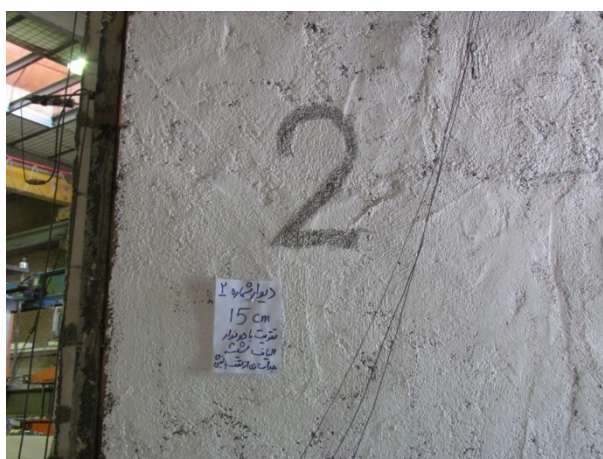
شکل (پ ۱-۱۴) نمایی از دیوار شماره (۲)
