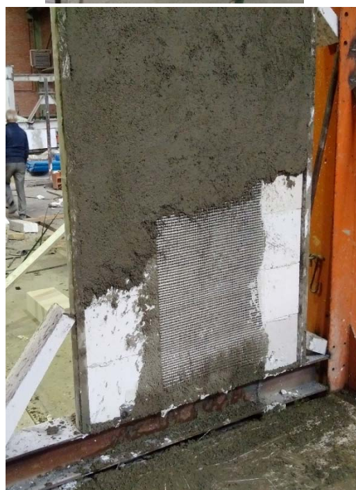
شکل (پ ۲-۵) جزئیات نصب مش الیاف شیشه بر روی دیوار AAC
