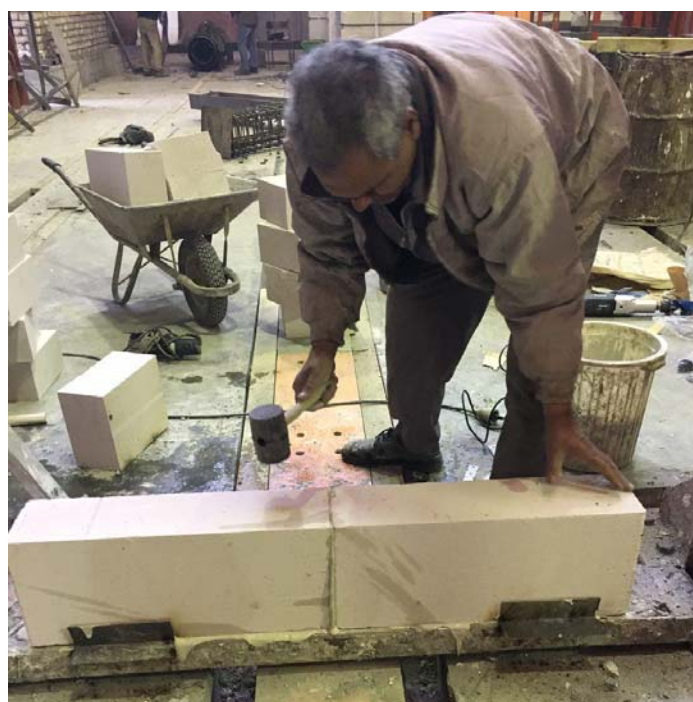
شکل (پ ۱-۷) ضربه زدن به بلوک‌ها برای از بین رفتن فضاهای خالی
