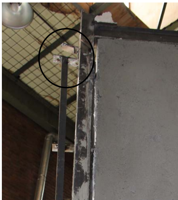
شکل (پ ۱-۲۳) فاصله بین قاب نگهدارنده دیوار (۳) و قاب سازه به همراه ورق افقی اتصال
