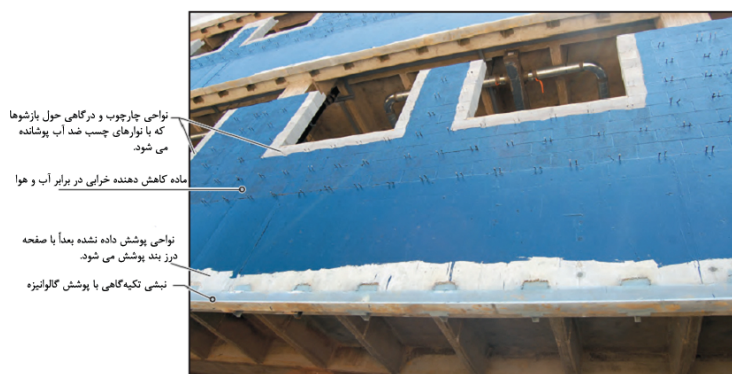
شکل ۵-۱۸ استفاده از ماده مخصوص کاهش دهنده خرابی در برابر آب و هوا قبل از اجرای نمای آجری
