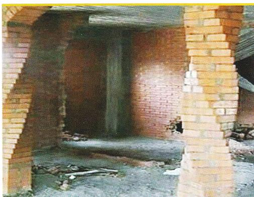
**۱- دیوار با مصالح بنایی (Masonry):** عملیات دیوارچینی که بروش بنایی به وسیله مصالح پایه معدنی یا صنعتی از جمله آجر، انواع بلوك (توپریا توحالی) سفالی، سیمانی، بتونی و سنگی که عموماً با ملات‌های سیمانی اجرا می‌شوند.
